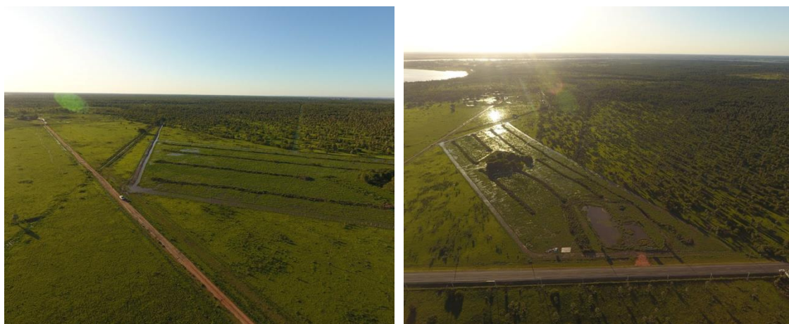
Imagen 10. Fotografías de la zona de obras
