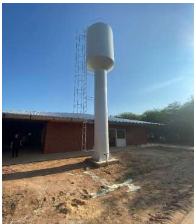
TANQUE DE AGUA
