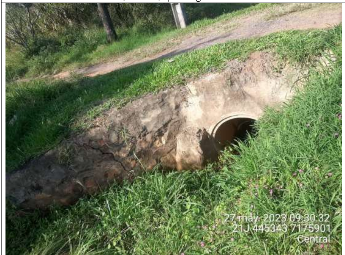
Alcantarilla instalada
