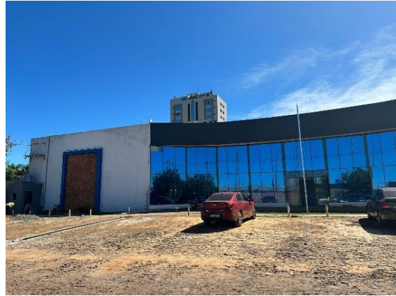
Fotografía 4. Fachada del edificio.
