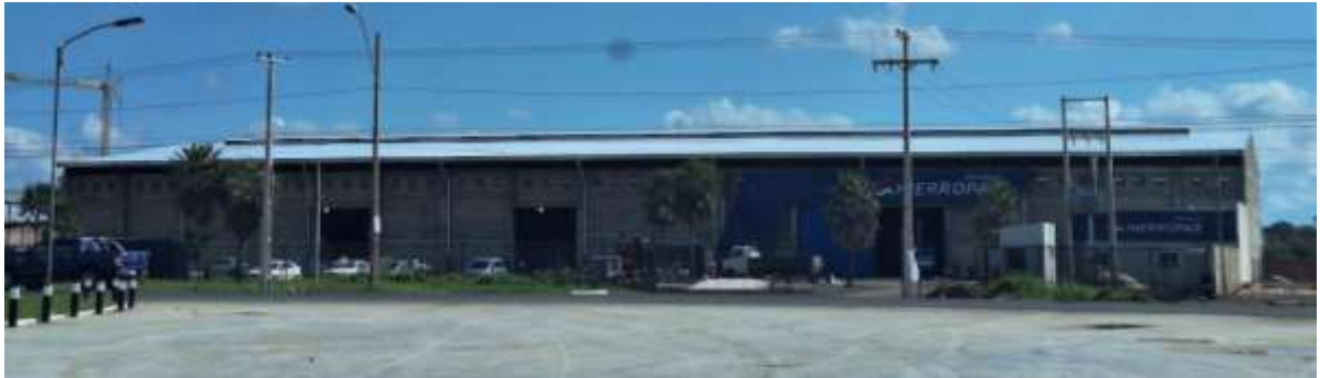
Fotografía 1: Vista frontal del predio
