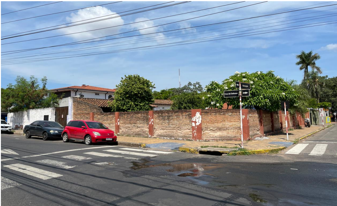
Vista del inmueble a ser intervenido
