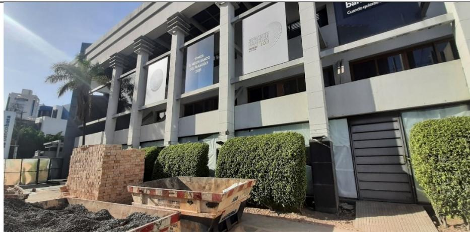
Foto 02-03-04. Zona de la fachada a demoler y ampliar.
