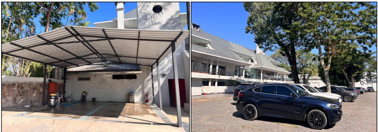
Fotografía 5. Vista del Sector lateral lavadero de vehículos, estacionamiento en predio posterior. Fuente: Relevamiento fotográfico
