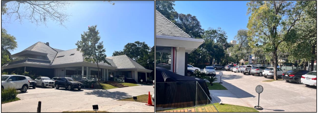
Fotografía 1. Vista del sector frontal exhibición de vehículos y estacionamiento clientes. Fuente: Relevamiento fotográfico
