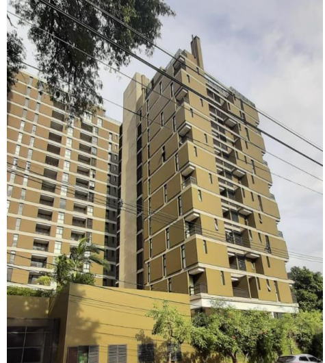
Fotos 04: Sobre la Avda. Santísima Trinidad se encuentra el complejo de Edificios Torres Mirador .
