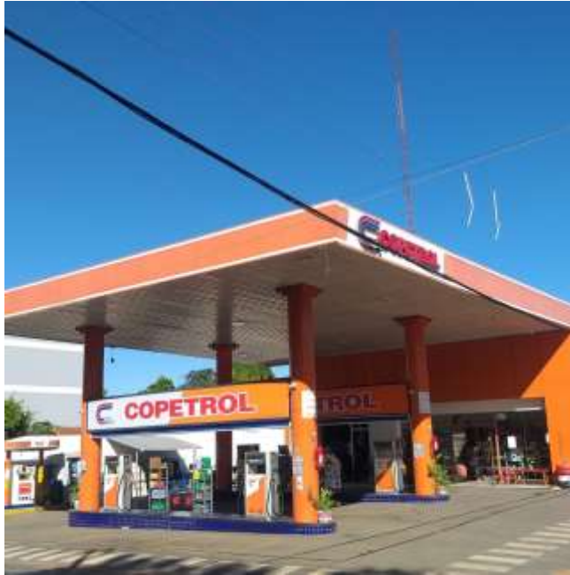
Vista general de la Gasolinera
