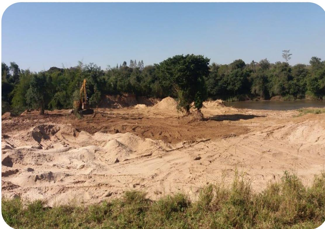
El proyecto corresponde a la Extracción de Arena (ARENERA), esta actividad será realizada en el canal del río Tebicuary, a partir de la depositada por el proceso de sedimentación de las zonas altas de la propiedad, depositada en la parte baja del terreno. Así mismo, se sustraerá la arena por medio de succión una plataforma de porte pequeño arenero.
