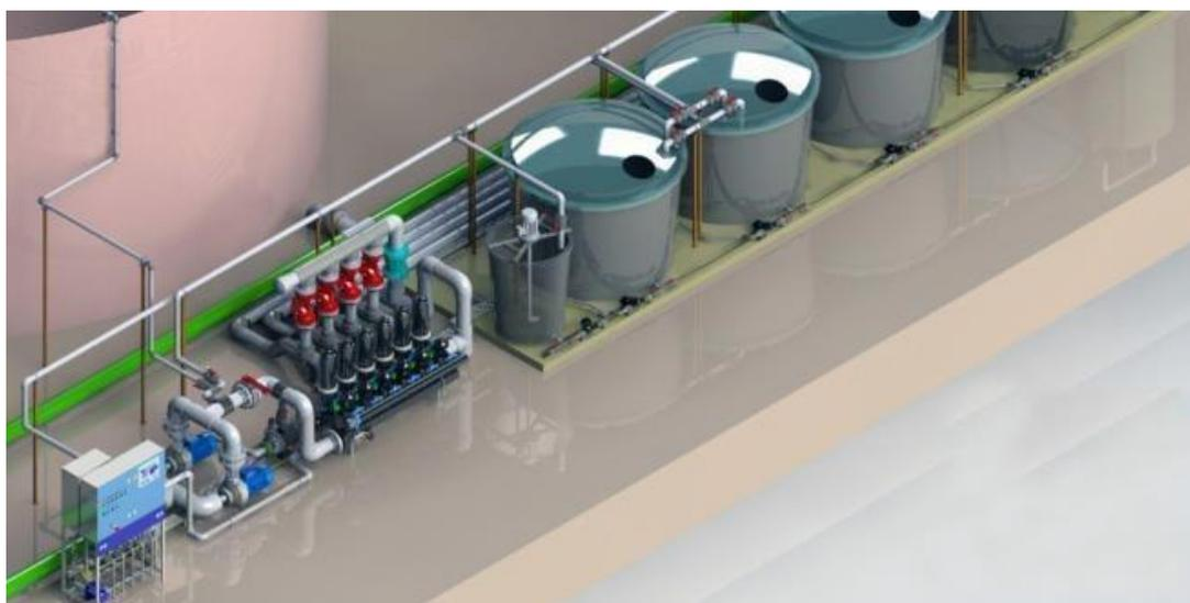
Equipo automático de fertirrigación La instalación incluye 1 equipo automático de fertirrigación para cubrir la demanda de riego diaria con las siguientes especificaciones:
