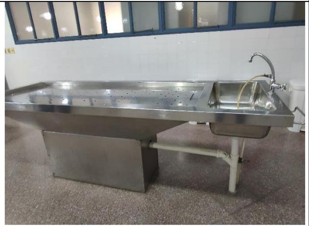
**Figura 2:** Mesa de autopsia de acero inoxidable empotrado en el piso con el servicio de agua y desagüe.
