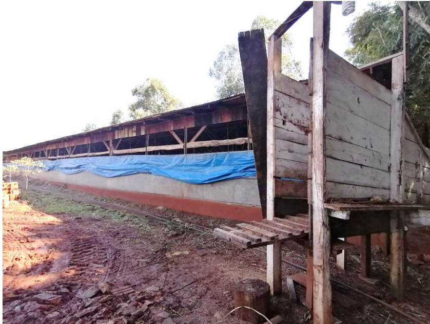
Vista de Galpón para engorde de cerdos
