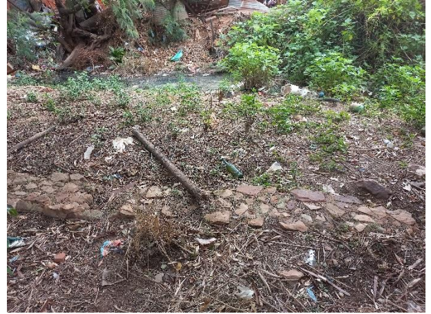
Imagen 14. Muralla perimetral de contención
