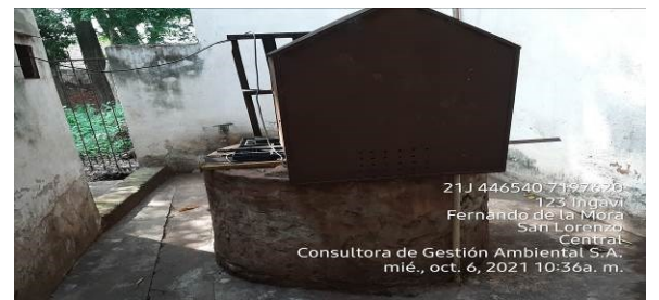
Foto 4. Pozo artesiano con coordenadas UTM: 21J 446.540 m E – 7.197.620 m S.
