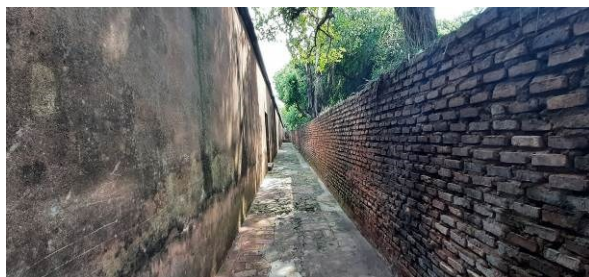
Foto 3. Espacio perimetral del depósito
