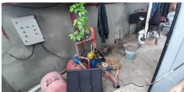
Foto 13. Sistema de bombeo de agua para sistema contra incendios. Reservorio de 30.000 l.
