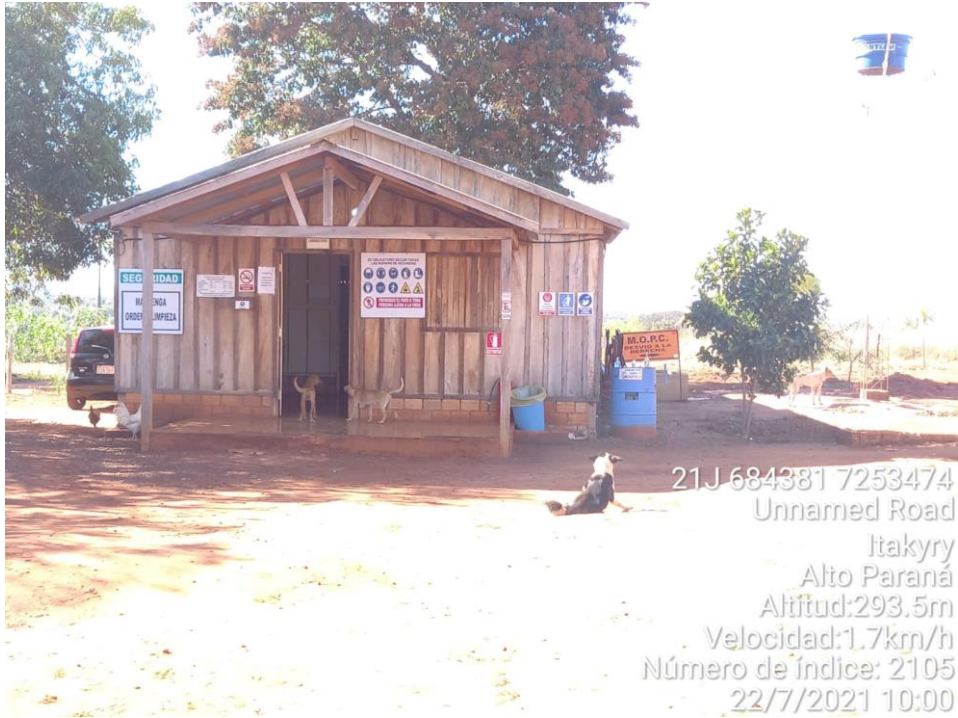
Registro fotográfico 1. de área de oficinas
