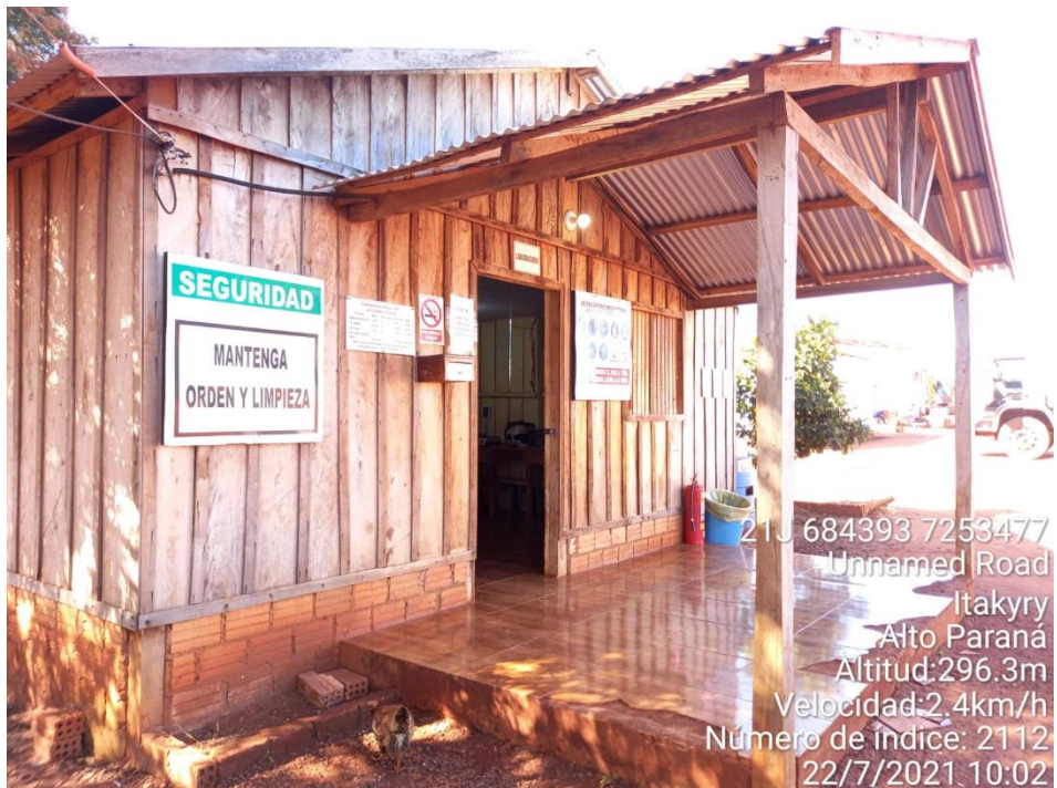
Registro fotográfico 2. de área de oficinas
