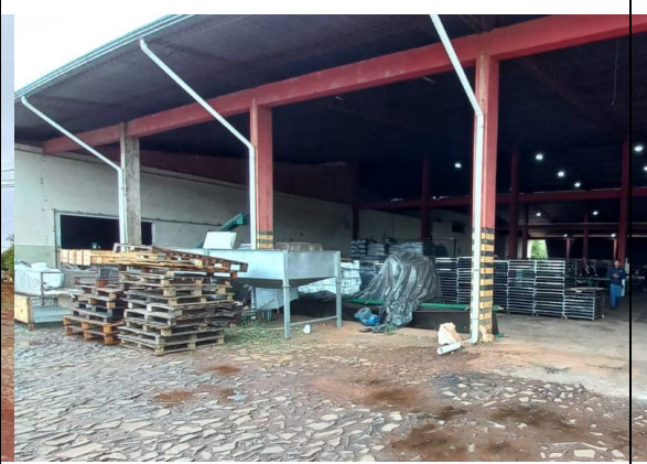
Foto 2: Vista de un costado del depósito.
