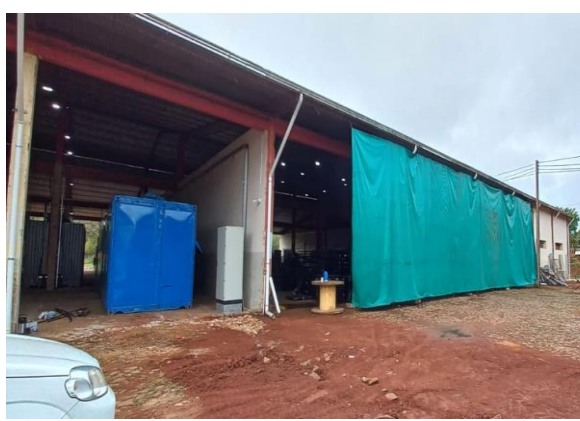
Foto 1: vista frontal del depósito.
