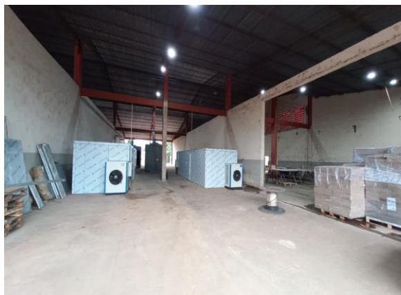
Foto 3: vista del interior del depósito.
