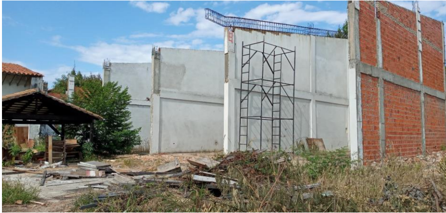
Vistas de la condición actual del inmueble e infraestructura a demoler
