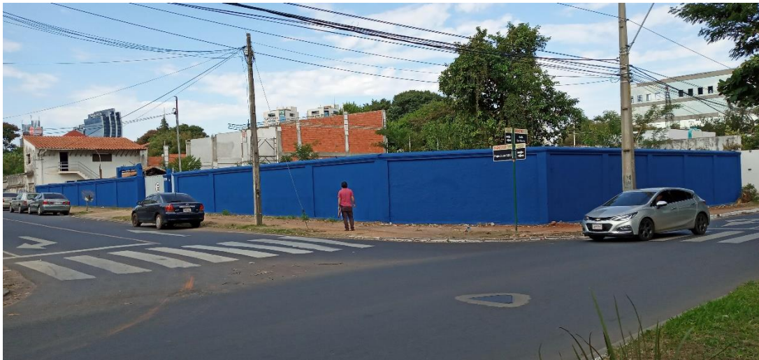
Vista del acceso al inmueble a ser intervenido.
