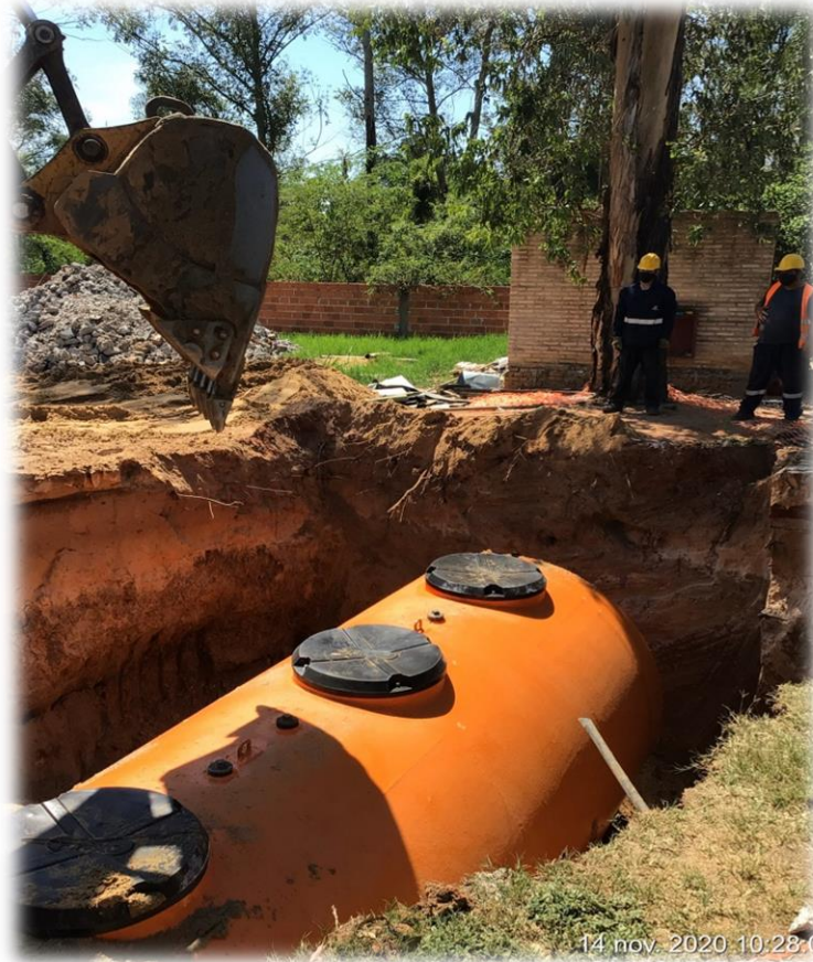
F1. Instalación de tanque de almacenamiento subterráneo de 30 m 3 .
