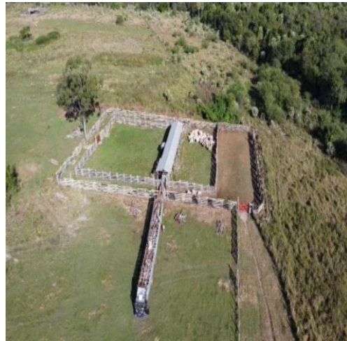
Foto N° 6 Vista aérea casco estancia
