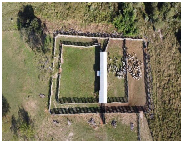
Foto N° 7 Vista aérea casco estancia
