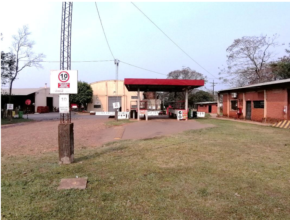
Señalizaciones para transportistas a su llegada a la planta y en la estación de control de productos
