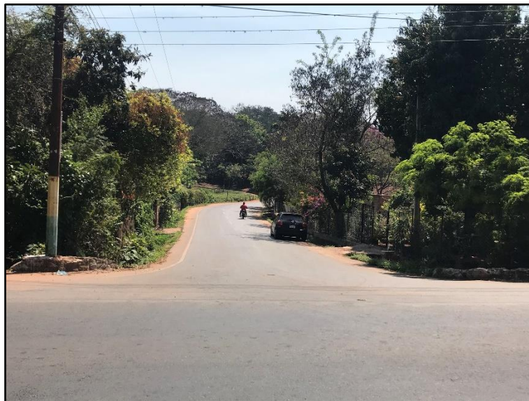
Figura 2 – Pavimentación asfáltica del Ramal Cabañas - Caacupé
