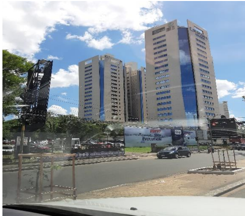
Foto 1. Edificio World Trade Center Asunción, sobre la Avenida Aviadores del Chaco.
