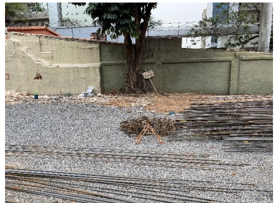
Foto 2. Muro por demoler para construir la ampliación del edificio The Top.
