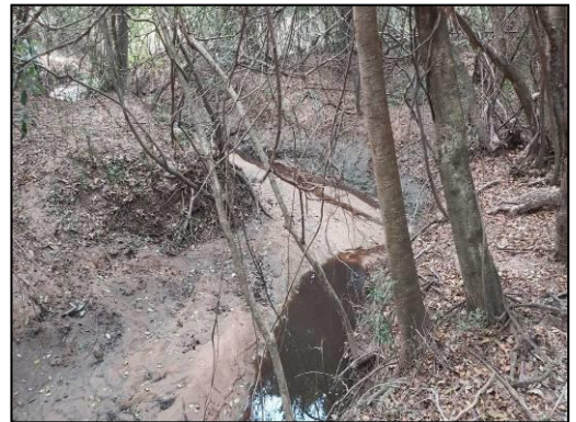
Foto N° 3: Arroyo zona nor/este
