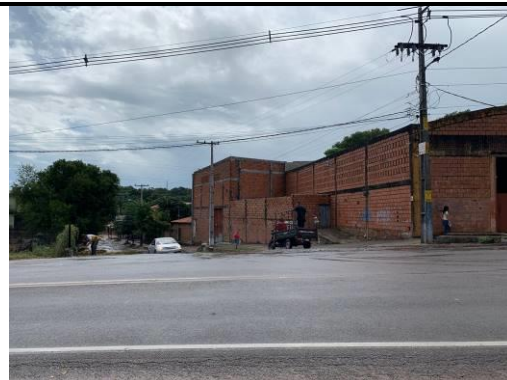
Fotografía 6. Cuarta cuadra del tramo de la LT 220 kV desde la subestación Villa Elisa (Avda. Defensores del Chaco y calle 23 de Julio). Coord.: 21 J 439541.17 m E – 7194343.95 m S
