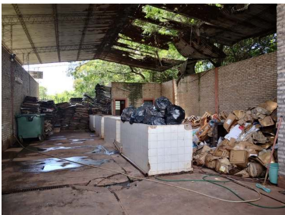
Disposición de residuos comunes – Depósito
