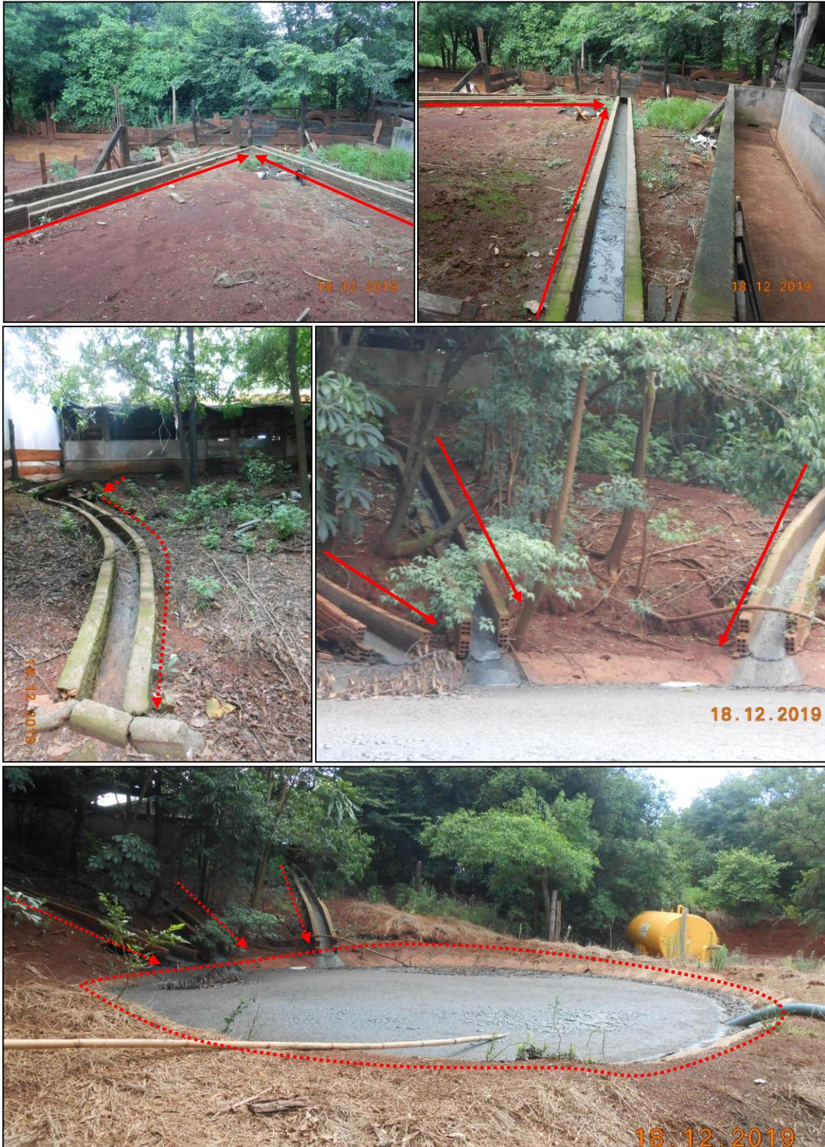
**Obs.:** Los efluentes líquidos se almacenan en una pileta impermeabilizada donde se realiza la decantación de los líquidos, de donde a través de un tanque pipa son extraídos de las piletas y utilizados para la ferti - irrigación en los cultivos cercanos existentes. Estas operaciones no son efectuadas constantemente, son realizadas trimestralmente de acuerdo a la necesidad del cultivo, o a la cantidad de efluentes generados.
