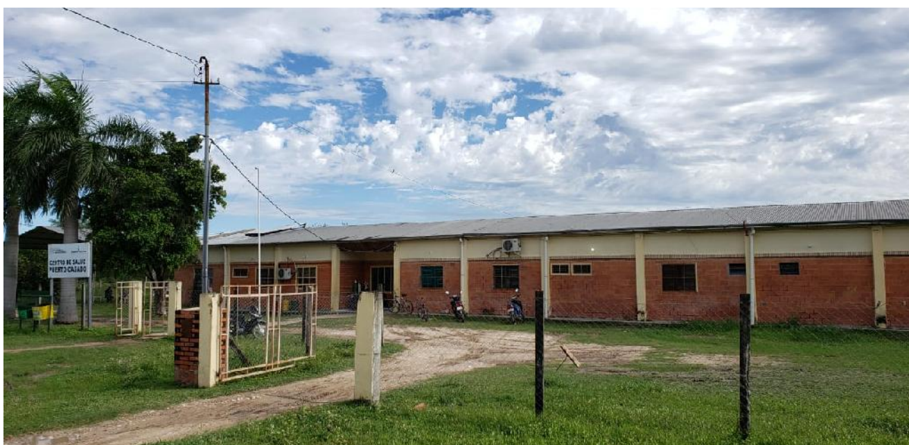
Accesos peatonal y vehicular con portones metálicos tipo reja y cerco perimetral de tejido de alambre
