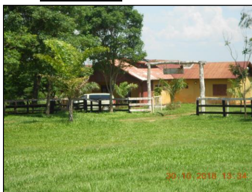
Foto N° 22: Área de Sede
