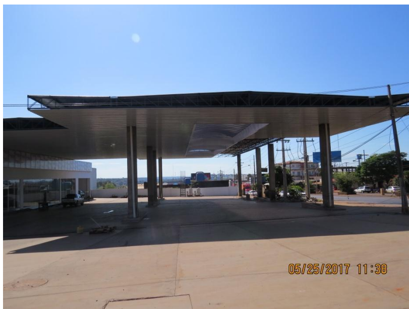
Vista de la estación de servicios en construcción
