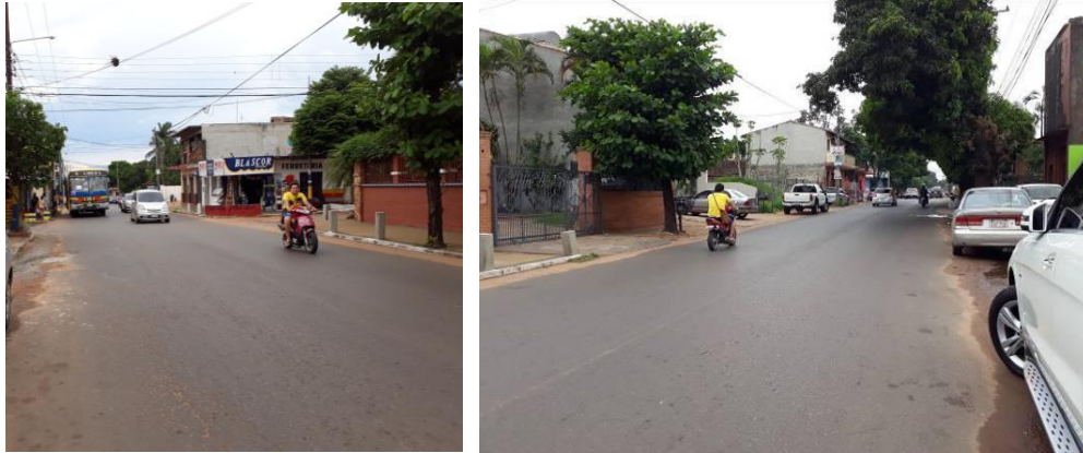
Vistas del emplazamiento propio de un área urbana
