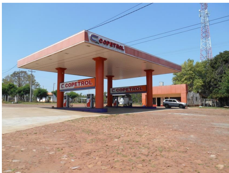
Vista de la estación de servicios en fase de terminación
