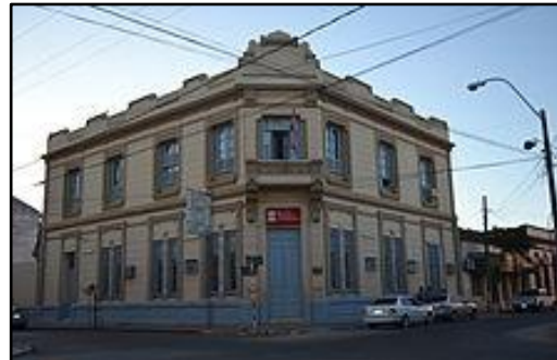
Edificio del Banco Nacional de Fomento.
