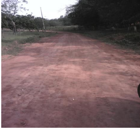
Foto N° 1 – Camino de ingreso
