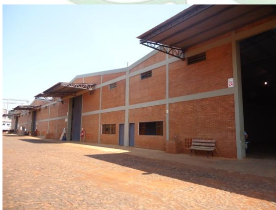
Fotografía 7. Depósitos de la empresa GICAL
