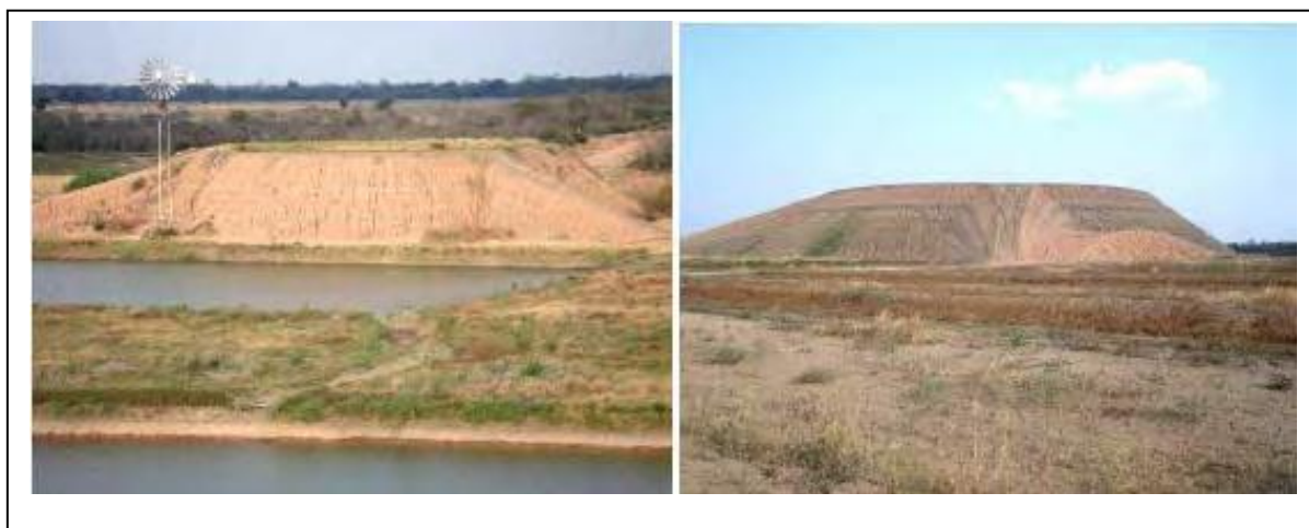
Figura 3: Muestra de tajamar pulmón, con instalación de molino de vientos y reservorio.
