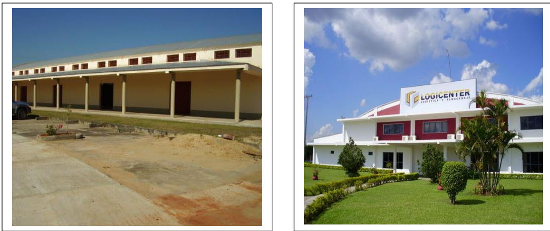
FIGURA N° 2 . EDIFICIO NSA LOGISTICA DE AEROPUERTO Y EDIFICIO DE LOGICENTER.
