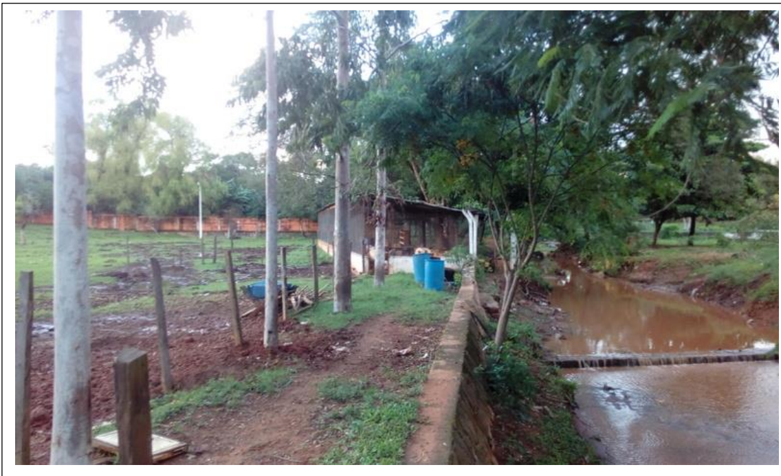
FIGURA N° 8. AREA A SER INTERVENIDA PARA LAS OBRAS DE MEJORA DE LA CANALIZACION DEL ARROYO.
