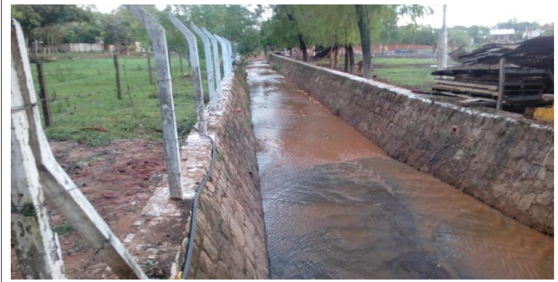
FIGURA N° 7. MUESTRA DE LA CANALIZACION DEL ARROYO TAYAZUAPE DENTRO DEL PREDIO.
