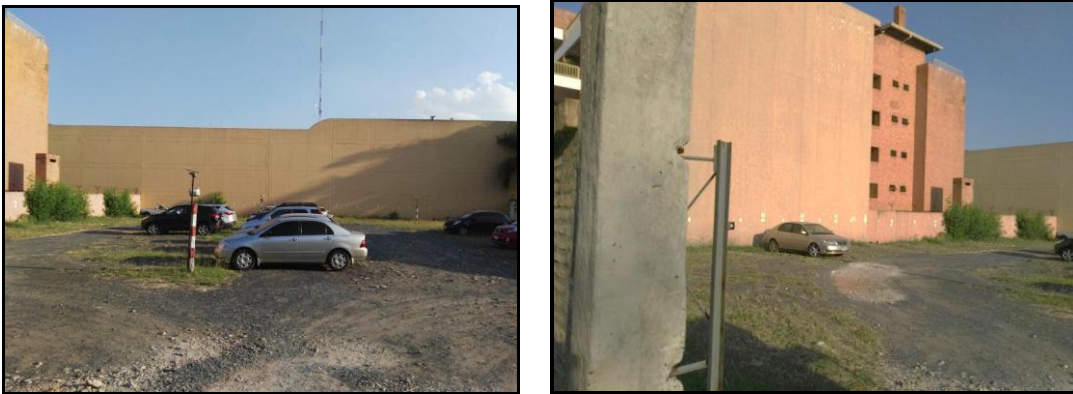
Vista del área a intervenir
