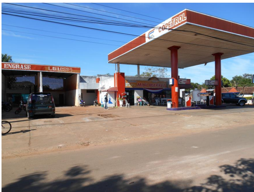
Vista Frontal de la Estación de Servicios
