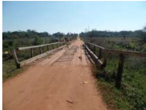
Fotografía 10. Puente Aº Héctor Cue
