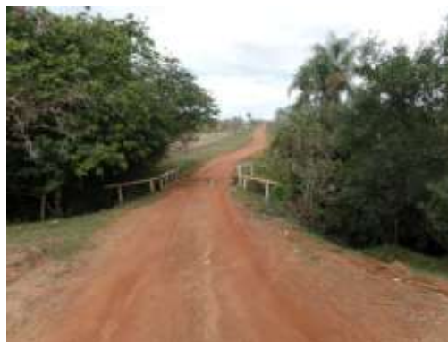
Fotografía 2. Puente Aº Mina, Cordillera
