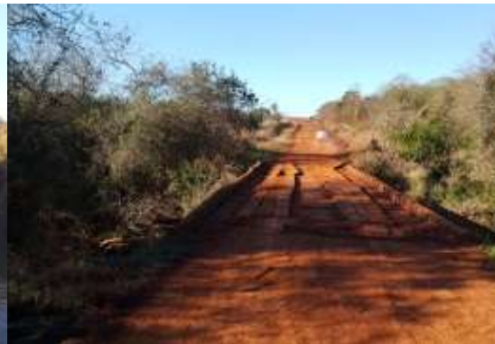
Fotografía 24. Puente sobre Aº Pirayui
