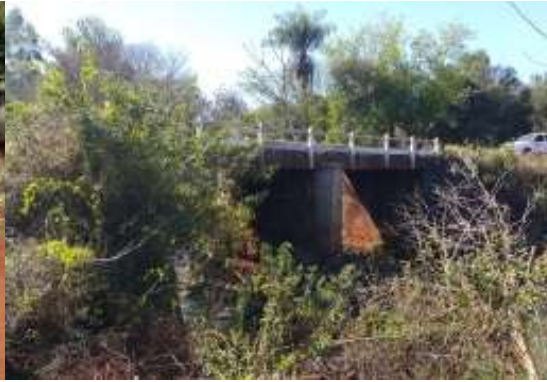
Fotografía 26. Puente sobre Aº Guazuy
