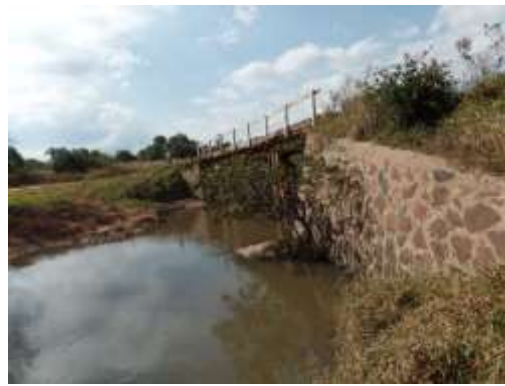
Fotografía 16. Puente sobre Aº Ita Paso
