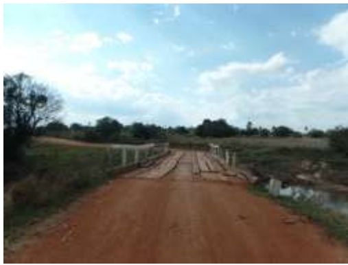
Fotografía 15. Puente sobre el Aº Paso Ita, Paraguari
