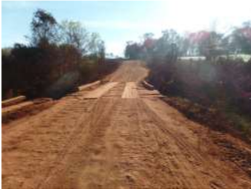
Fotografía 19. Puente sobre el Aº Aguapey. Edelira km 40 – Itapúa
