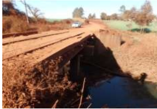
Fotografía 20. Puente sobre Aº Aguapey
