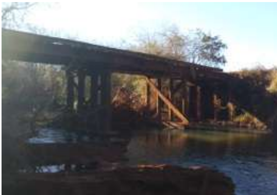
Fotografía 23. Puente sobre el Aº Pirayui, Itapúa
