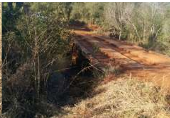
Fotografía 28. Puente sobre Aº Guarapay
