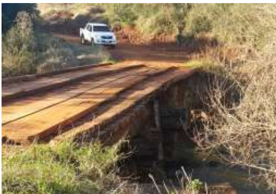
Fotografía 27. Puente sobre el Aº Guarapay, Itapúa
