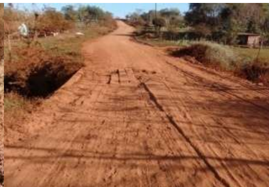
Fotografía 22. Puente sobre Aº s/n Km 55 Edelira
