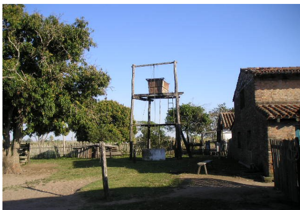
Sistema de abastecimiento de agua. Pozo común con Tanque de fibrocemento elevado.
